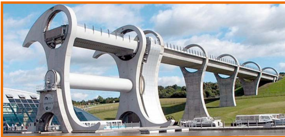
Una fantascientifica e un po' inquietante ruota in acciaio alta 24 metri, capace di sollevare delle intere chiatte e battelli carichi di passeggeri è la Falkirk, una delle attrazioni della Scozia. Consente alle imbarcazioni di superare il dislivello tra Forth and Clyde (vicino Edinburgo) e Union Canal e accedere al Roughcastle Tunnel. http://www.thefalkirkwheel.co.uk/ Della serie: gli altri Paesi progrediscono.
