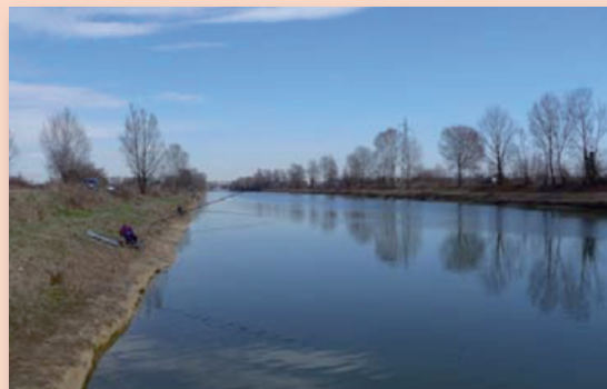
L'idrovia di Saonara
